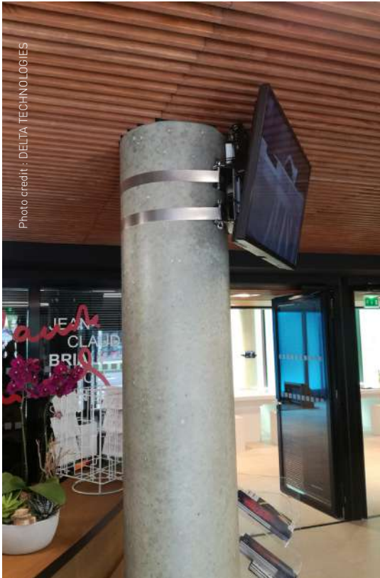
Installation d'un cerclage poteau Intégrateur : DELTA TECHNOLOGIES
